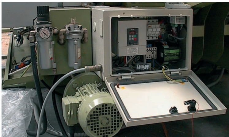
Cassetta controllo motore posizionario spalla mobile di una bordatrice tipo bi-spalla.
